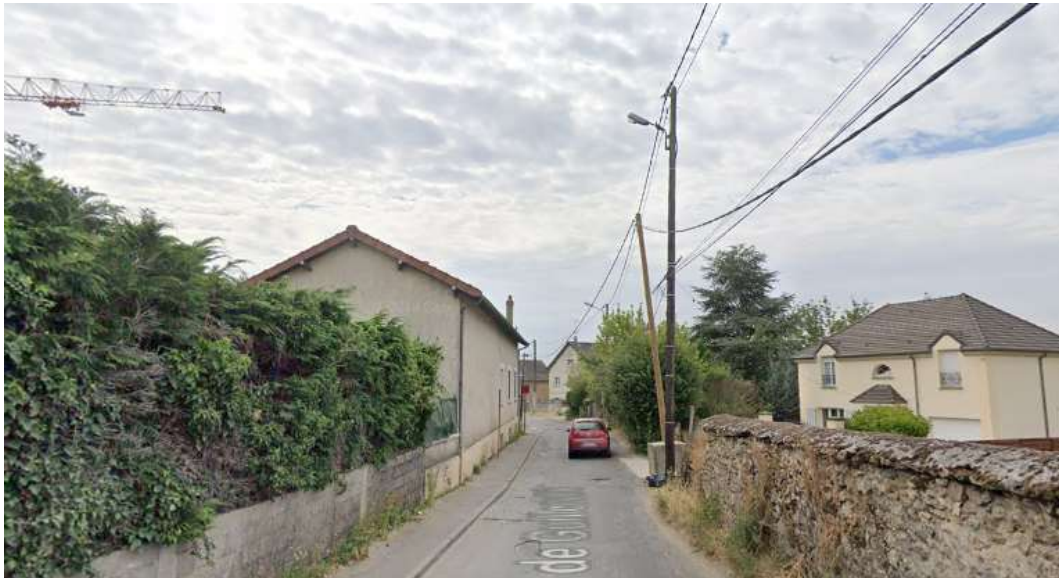
Réseaux aériens sur la partie haute de la rue de Guillerville
