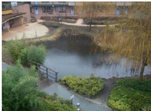
Figure 44 : Marre d'infiltration (Rombaut, 2010)
