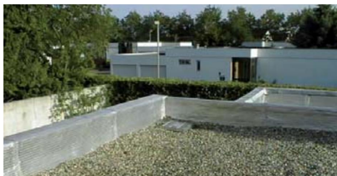
Figure 51 : Toiture-terrasse stockante (Communauté Urbaine du Grand Lyon, 2008)
