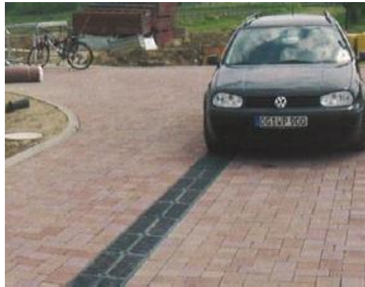
Figure 48 : Exemple de caniveau filtrant infiltrant (Funke)
