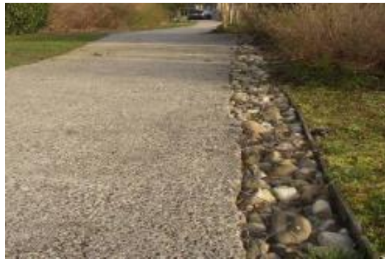
Figure 47 : tranchée d'infiltration, ZAC des chênes, Corbas (Communauté Urbaine du Grand Lyon, 2008)
