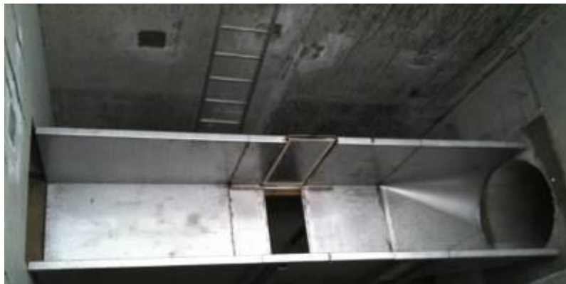
Figure 95 : Photo d'un piège à charriage à Marseille
