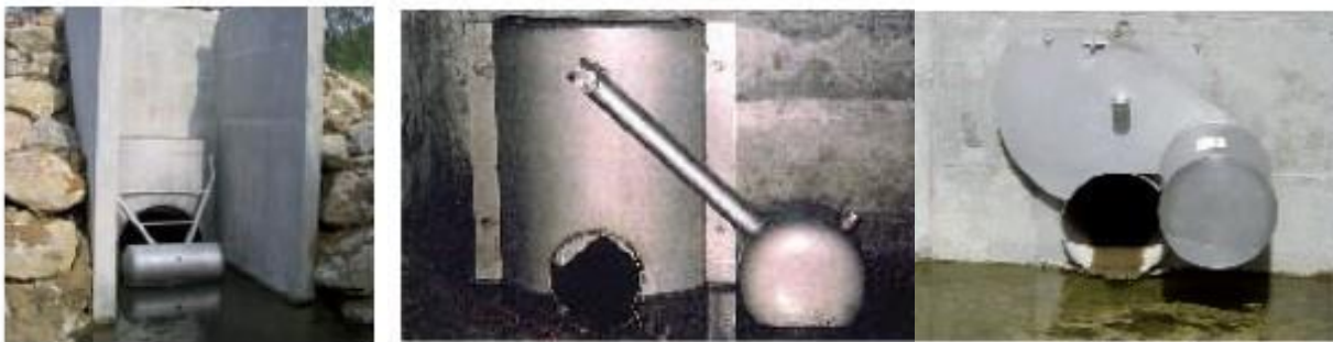
Figure 126 : Régulateurs à flotteur (Saint Dizier environnement)
