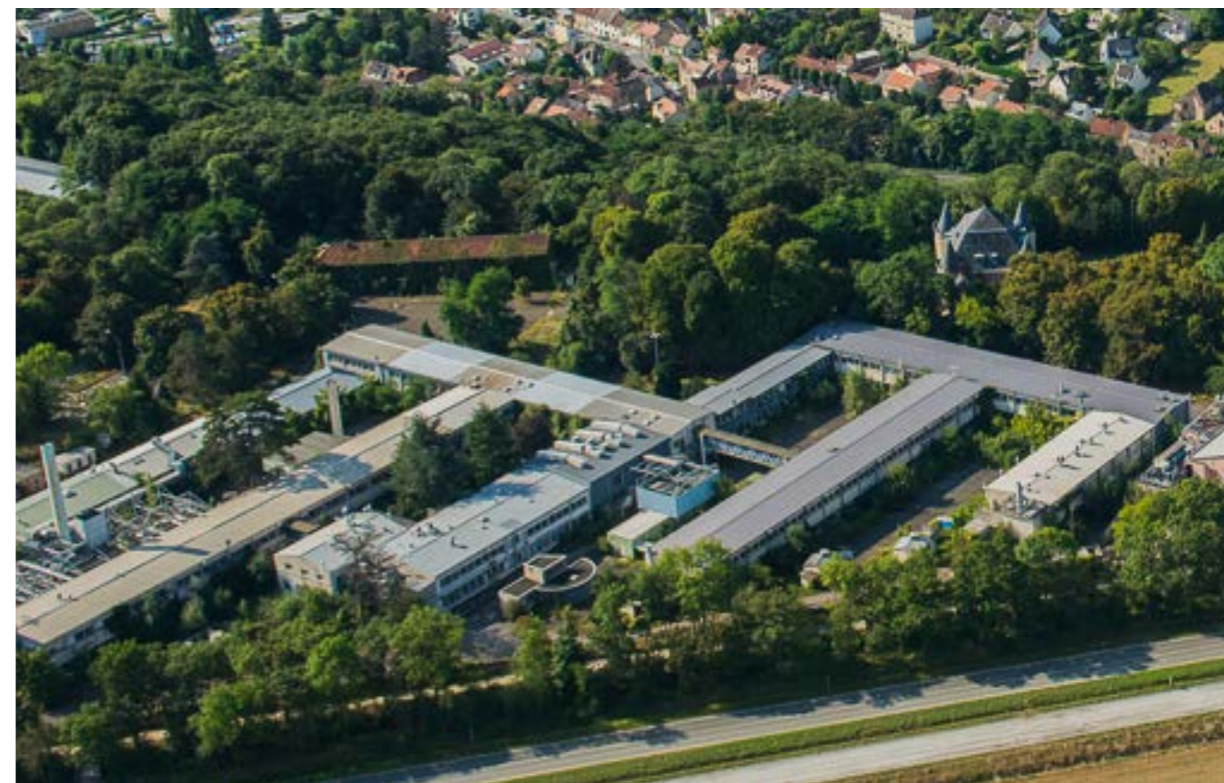
Vue aérienne de la friche industrielle de Thalès (source EPA Paris-Saclay, 2017)
