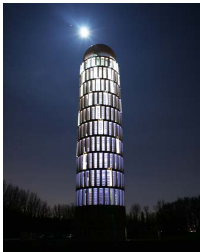
Vue du radar Paris Sud-Palaiseau (source David Charetier, 2018)
