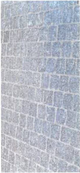
Figure 77. Pavés granit mis en oeuvre au sein des espaces majeurs de QEP (teinte gris-bleuté 10x10x10cm, type Lanhélin)
