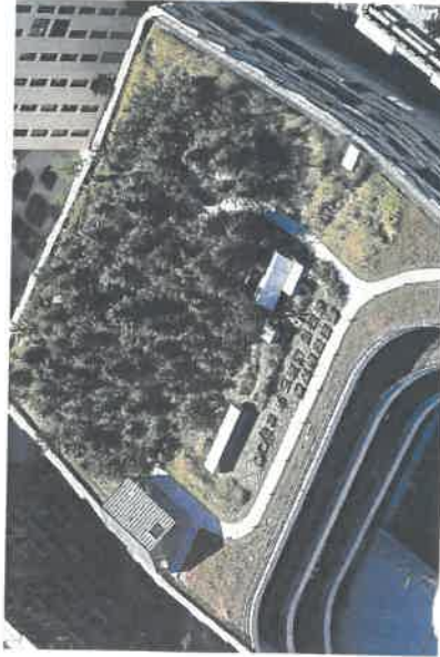
Figure 72. Plantation des cours en toiture – Ecole primaire des Sciences et de la Biodiversité, Boulogne Billancourt
