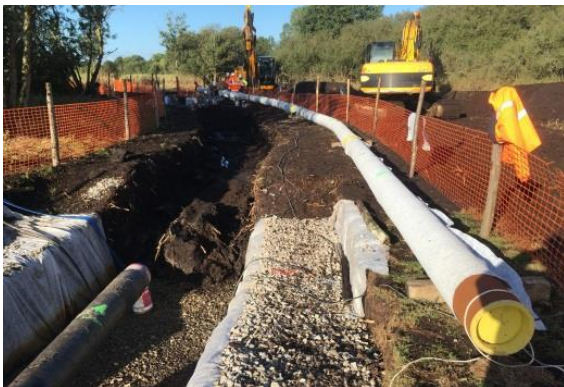
Chantier de réparation de revêtement de canalisation /changement de tronçon de canalisation
