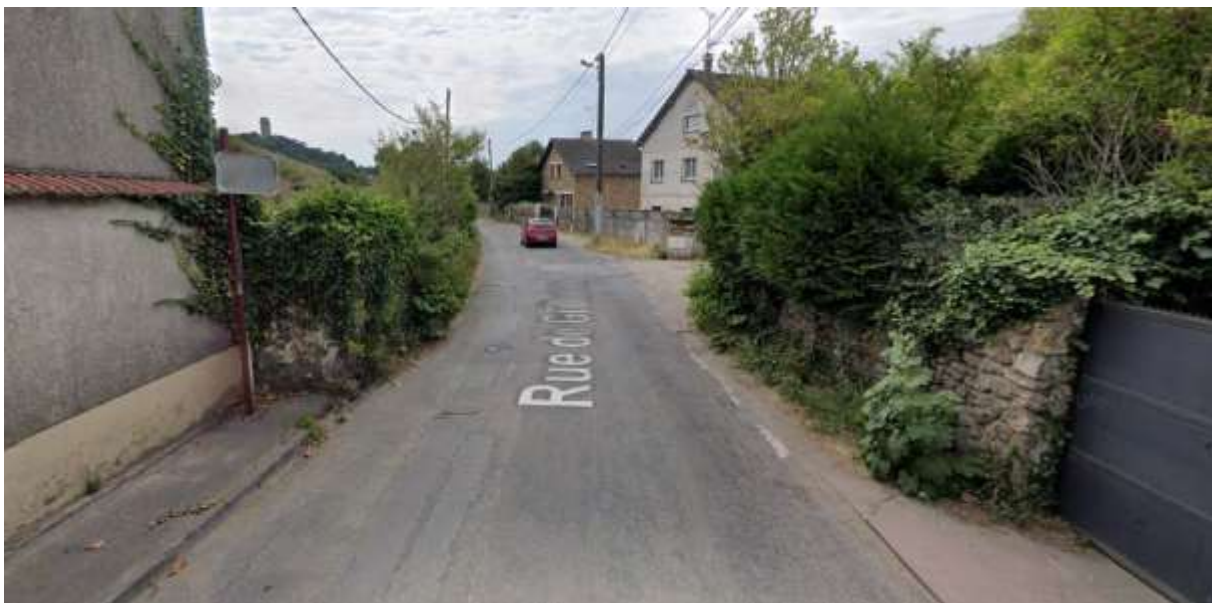
Absence de cheminement piéton rue de Guillerville
