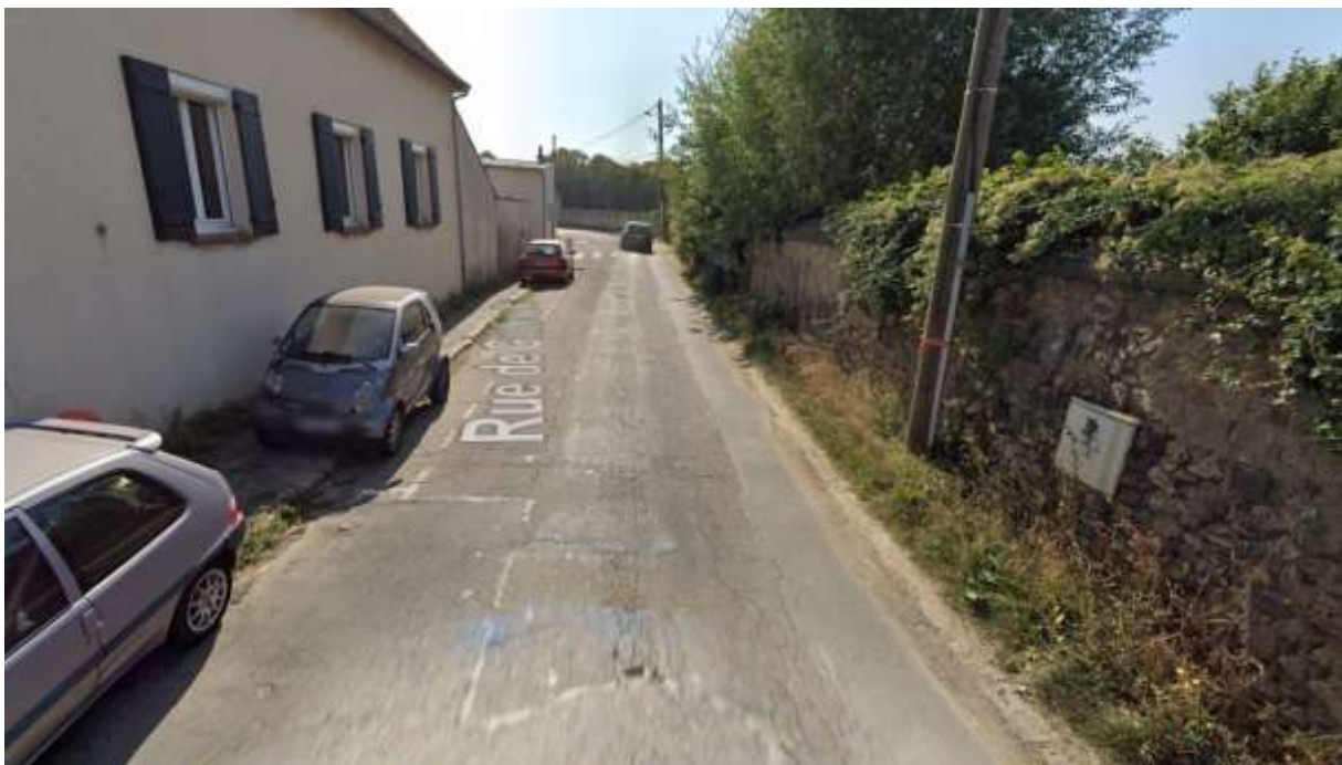
Vue de l'existant sur la rue de Guillerville (avant rénovation de la couche de roulement)
