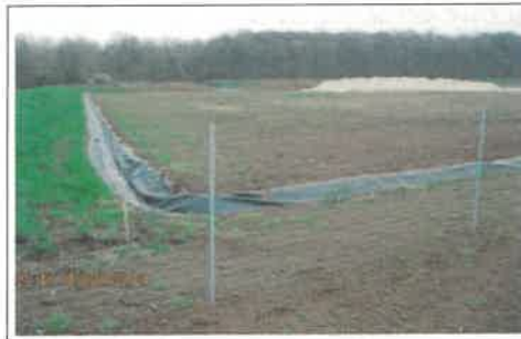
Fossés autour des installations de chantier (Source : SYSTRA)
