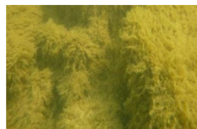
Photo 16 : Colmatage très fort observé sur les blocs
