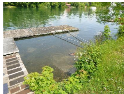
Photo 20 : Extrémité amont de HL3 (entre les deux ponton)
