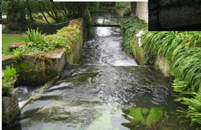
Passerelle et seuil
