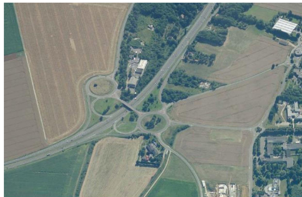
Figure 1. Vue aérienne de l'échangeur actuel.
