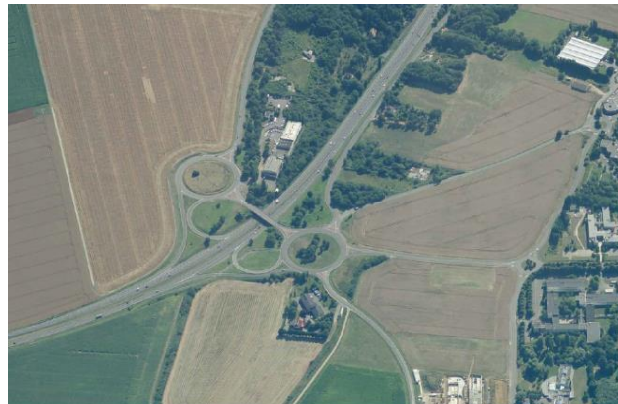
Figure 1. Vue aérienne de l'échangeur actuel.
